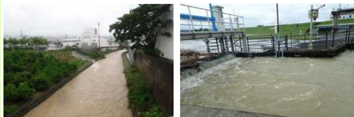
農業用の用排水路の増水状況
