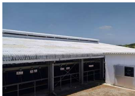
写真2 消石灰塗布により白くなった屋根
