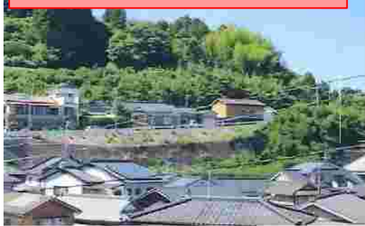
急傾斜地崩壊対策事業(長島町 福浦地区)
