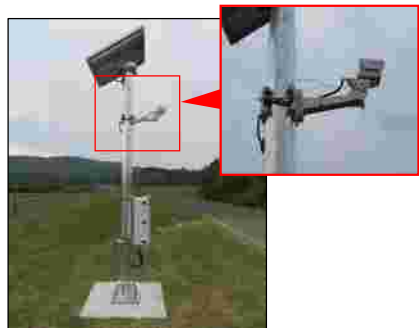
簡易型河川監視カメラ
