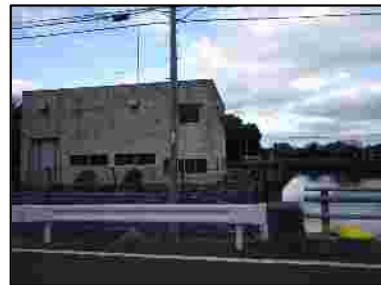
【折多排水機場】
