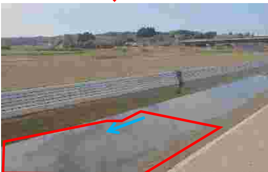
【施工後】折口川
