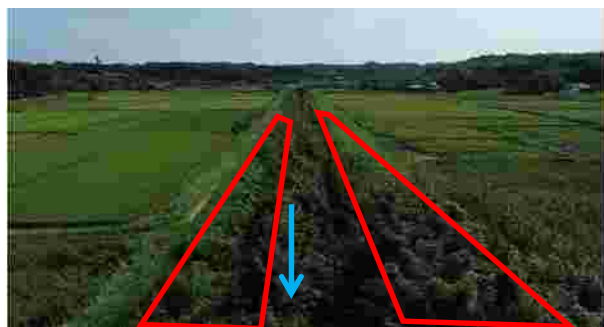
【施工前】折口川
