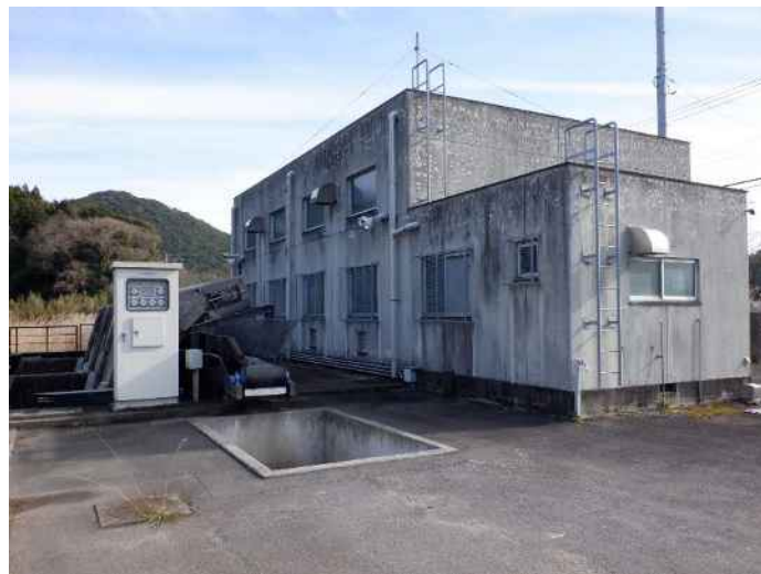
網津排水機場
