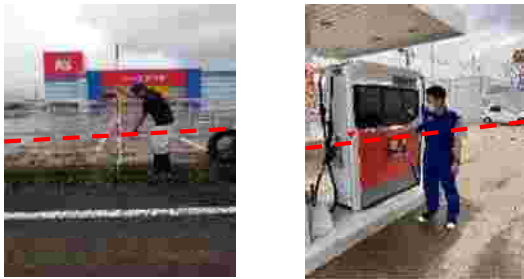
浸水状況調査で浸水高さを確認
