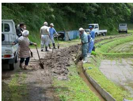
水路の泥上げ
