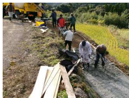
未舗装農道の舗装
