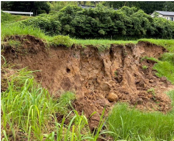
法面の崩れ(田)
