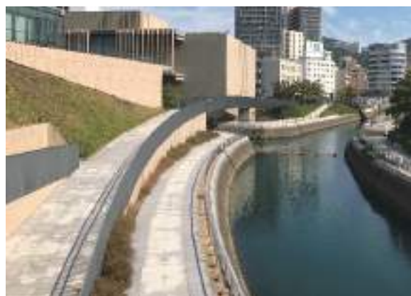
写真 6-33 スロープの設置
