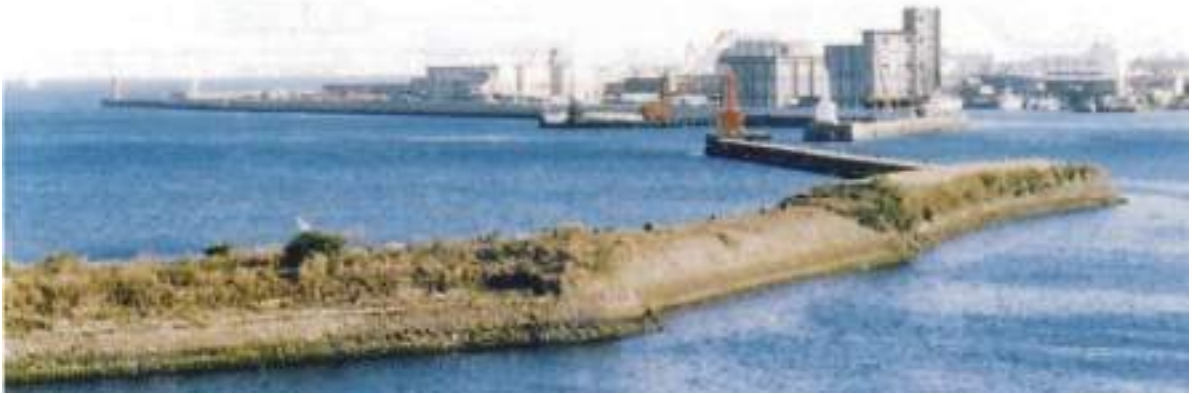
写真 2-4 1982(昭和 57)年頃の防波堤(新波止, 遮断防波堤, 一丁台場)と赤灯台(鹿児島旧港北防波堤灯台)
