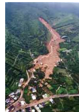
写真-5 平成9年針原川被害状況
