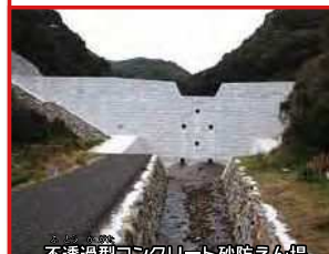
不透過型コンクリート砂防えん堤
