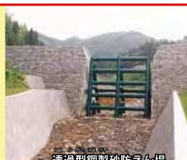
透過型鋼製砂防えん堤
