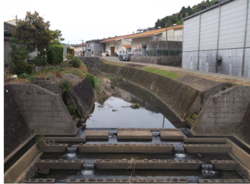
図 2-6 神手橋上流の取水堰
