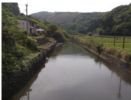
図2-1 小浜橋上流の様子
