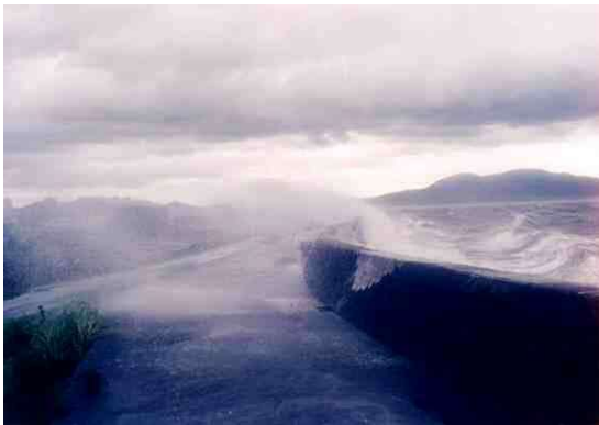
越波による被害1 (出水市)
