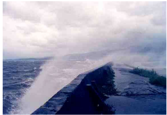
越波による被害2 (出水市)
