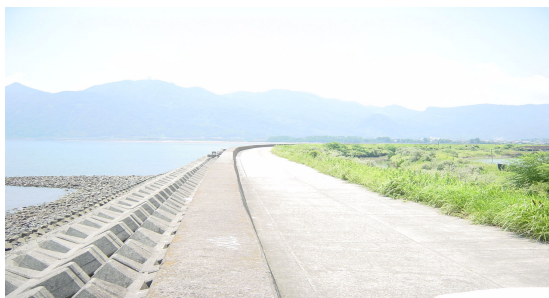
高潮からの防護施設 (始良海岸松原地区 始良市)
