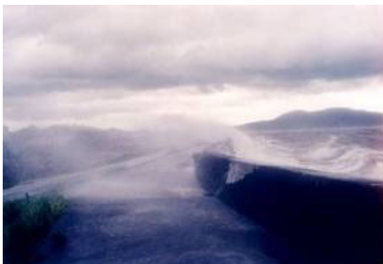
越波による被害 1 (出水市)
