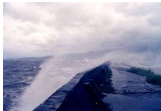
越波による被害 2 (出水市)
