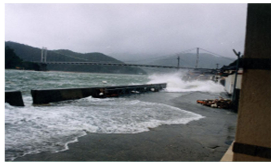
越波による被害(上天草市龍ヶ岳町)
