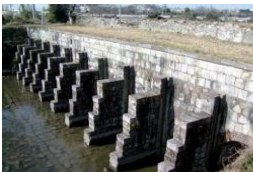
旧郡築新地甲号樋門(八代市)
