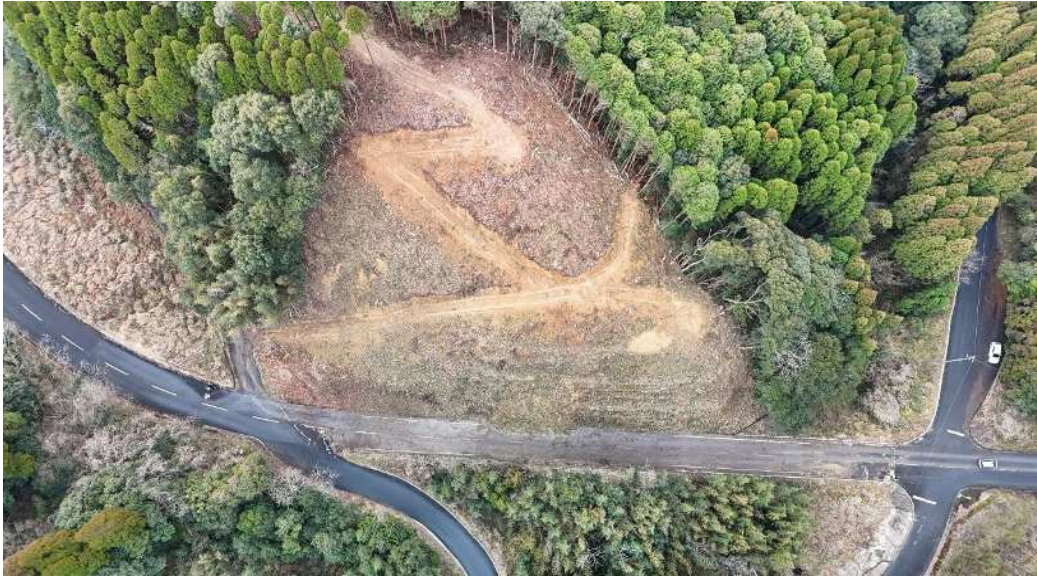
令和4年7月21日～5月7日の地すべりによる被災直後 グリーンロード4号線（さつま町）
