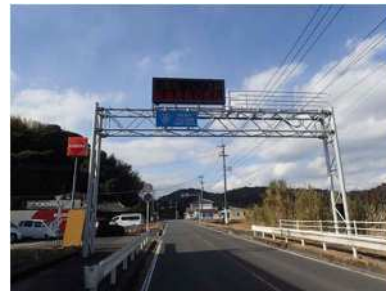
※門型支柱を有する大型の道路標識 及び道路情報提供装置
