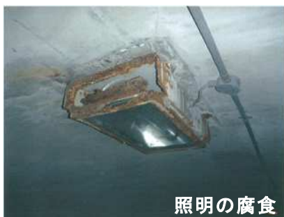
図 1-10 トンネル内附属物の損傷事例
