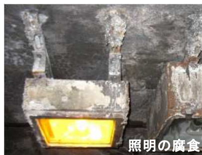
図 1-10 トンネル内附属物の損傷事例
