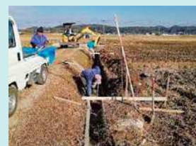
側溝の敷設（直営施工）
