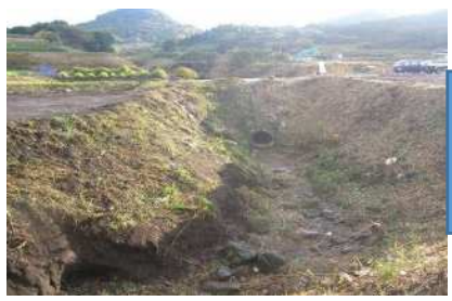
【用水排水施設整備】
