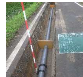
パイプライン
