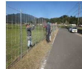
侵入防止柵の整備支援
