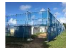
（防風ネットの設置）
