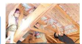
空き家改修ワークショップ
