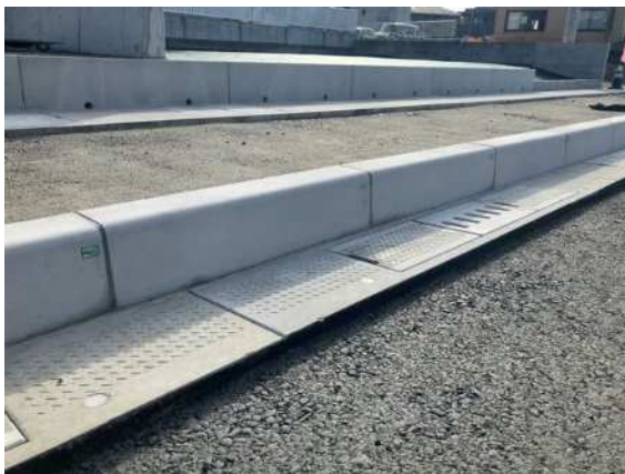
火山ガラス微粉末(VGP)を活用した 低炭素型コンクリート二次製品 (歩車道境界ブロック)
