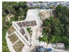
斜面の崩壊対策工事
